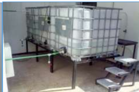
Réservoirs de stockage (Permeat, Retentat et eau brute)
